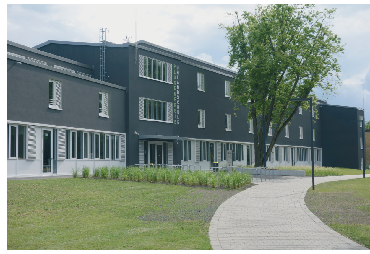
Abb. 3: Eine Altbauschule wird zur Plusenergieschule: Die Uhlandschule in Stuttgart-Zuffenhausen. Foto: Bareis
