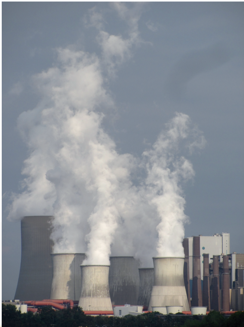
Abb.1: Braunkohlekraftwerk im Rheinland. Braunkohlekraftwerke emittieren pro kWh das meiste CO 2 ; noch fallen kaum Kosten für deren hohen Emissionen an. Foto: Bareis
