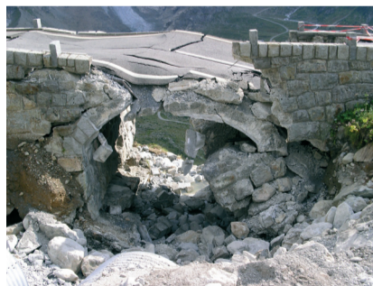
Abb. 3: Zerstörte Brücke nach einem Starkregen in den Alpen.
